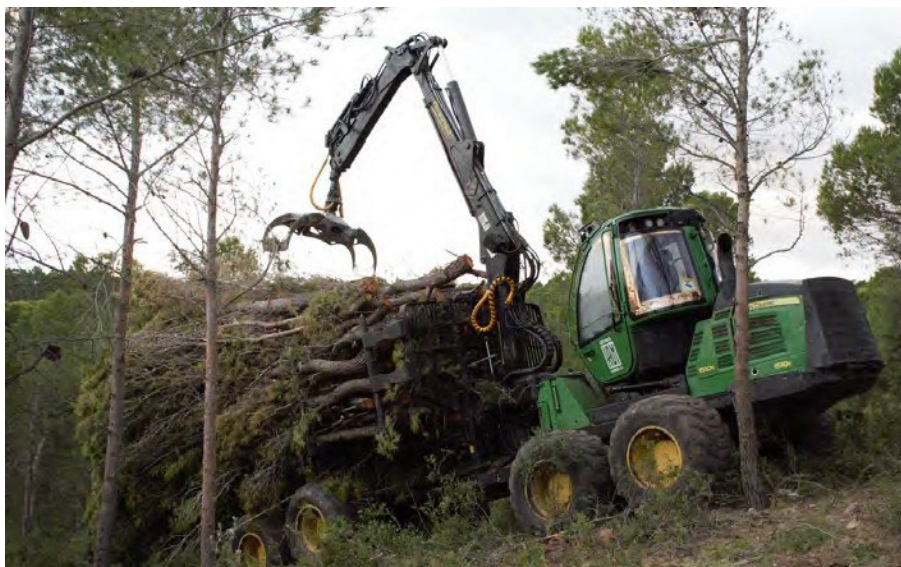
IMAGEN 6. AUTOCARGADOR A EMPLEAR EN OBRA
